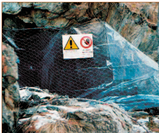
Foto 4 Imbocco di una galleria
