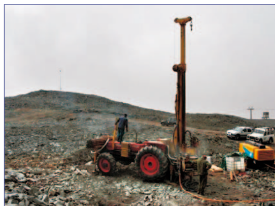
Figura 2 Realizzazione dei fori per il monitoraggio termico
