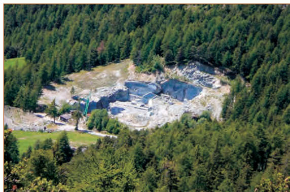
Cava a cielo aperto.
