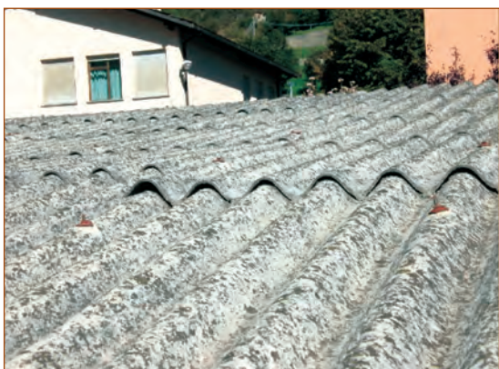
Figura 1 Lastre ondulate di cemento-amianto.
