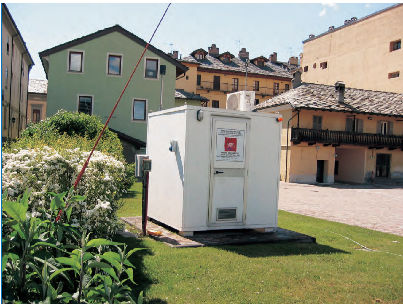
Centralina di monitoraggio della qualità dell'aria
