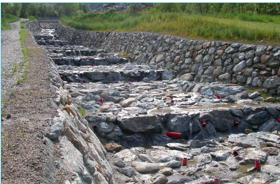
Figura 5 Corpo idrico fortemente modificato - Torrente Saint-Marcel Saint-Marcel
