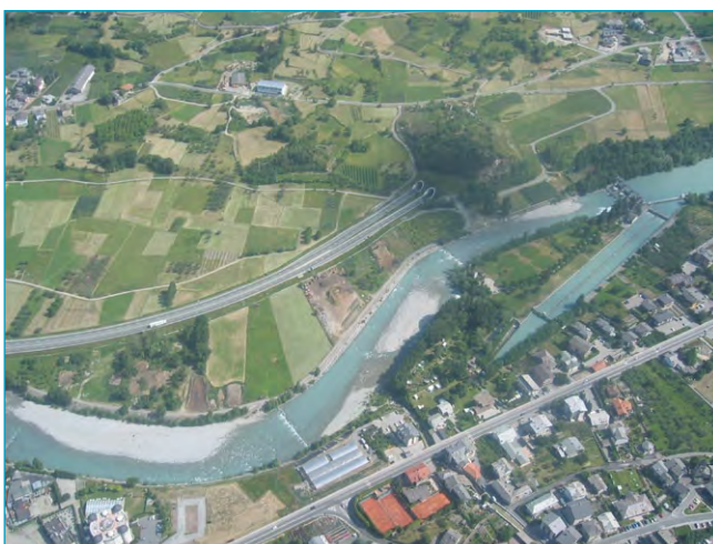
Figura 6 Derivazione idroelettrica sulla Dora Baltea (Valle d'Aosta - Comune di Sarre)
