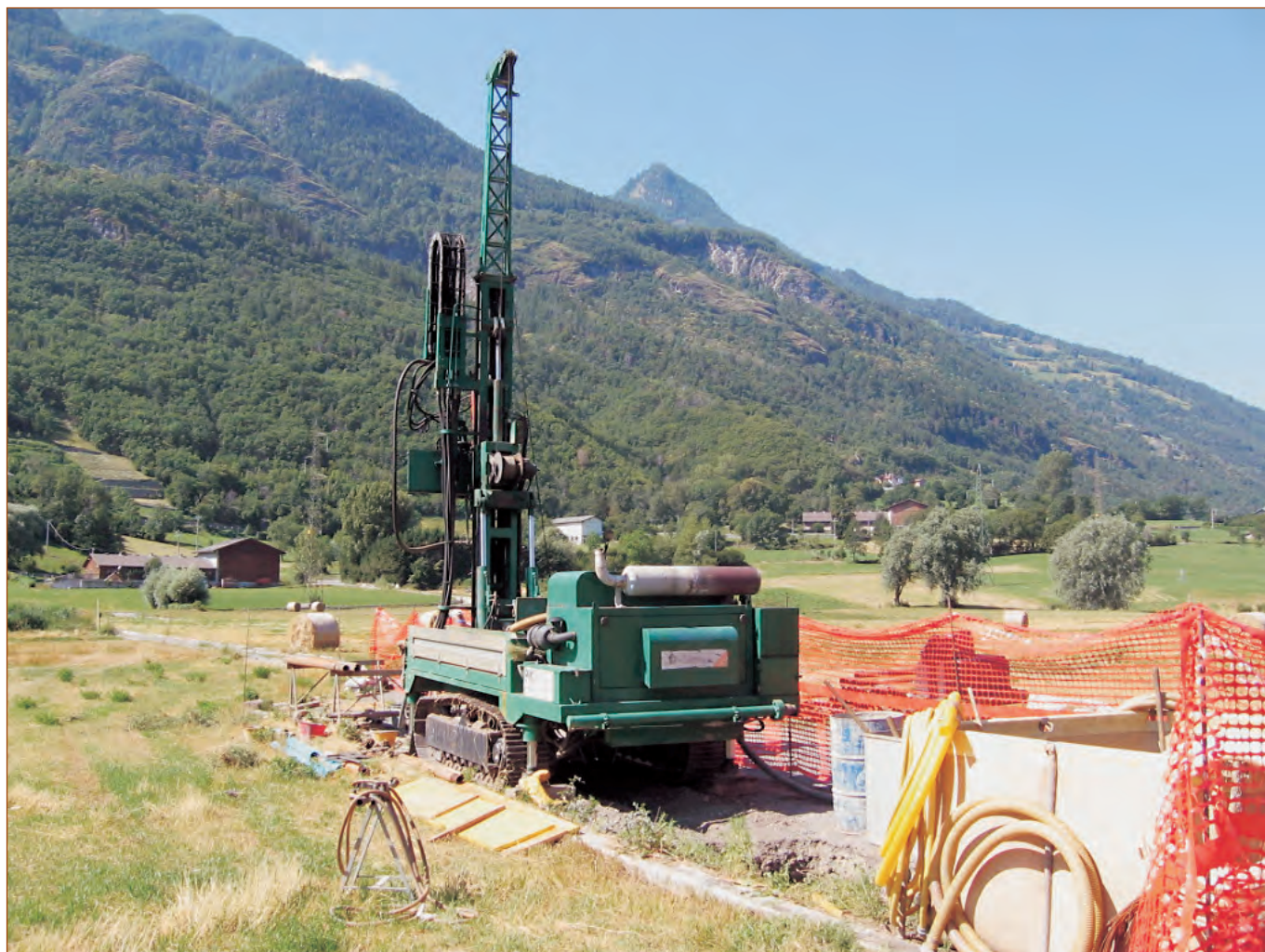
Perforazione piezometro - estate 2010
