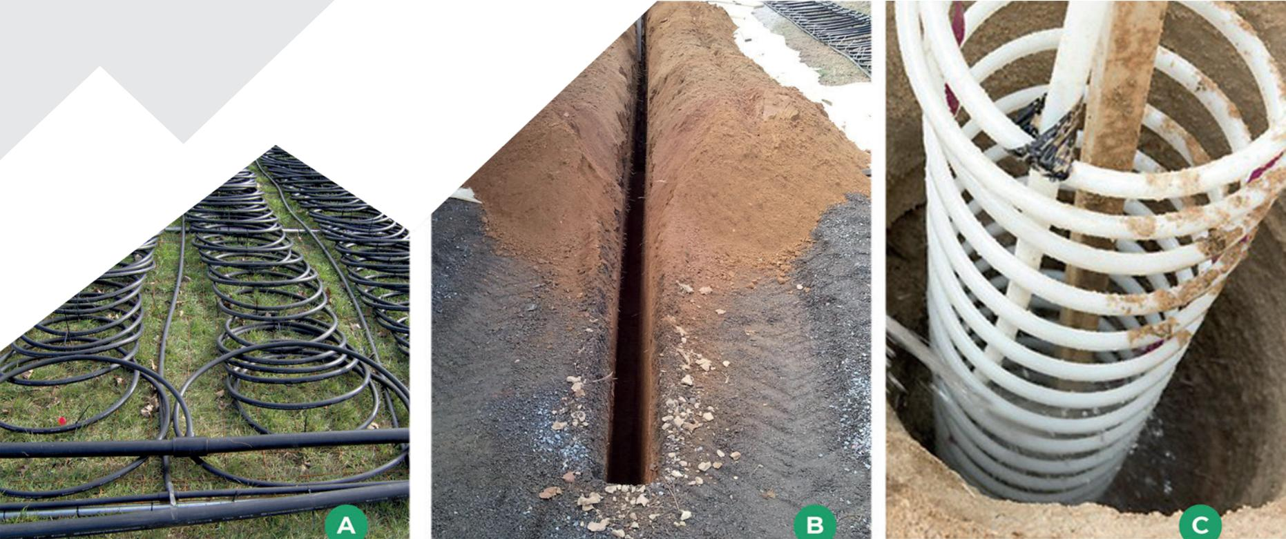
**Fig. 8:** Sistemi orizzontali a circuito chiuso: serpentina (A), lineare in trincea (B), basket geotermico (C).
