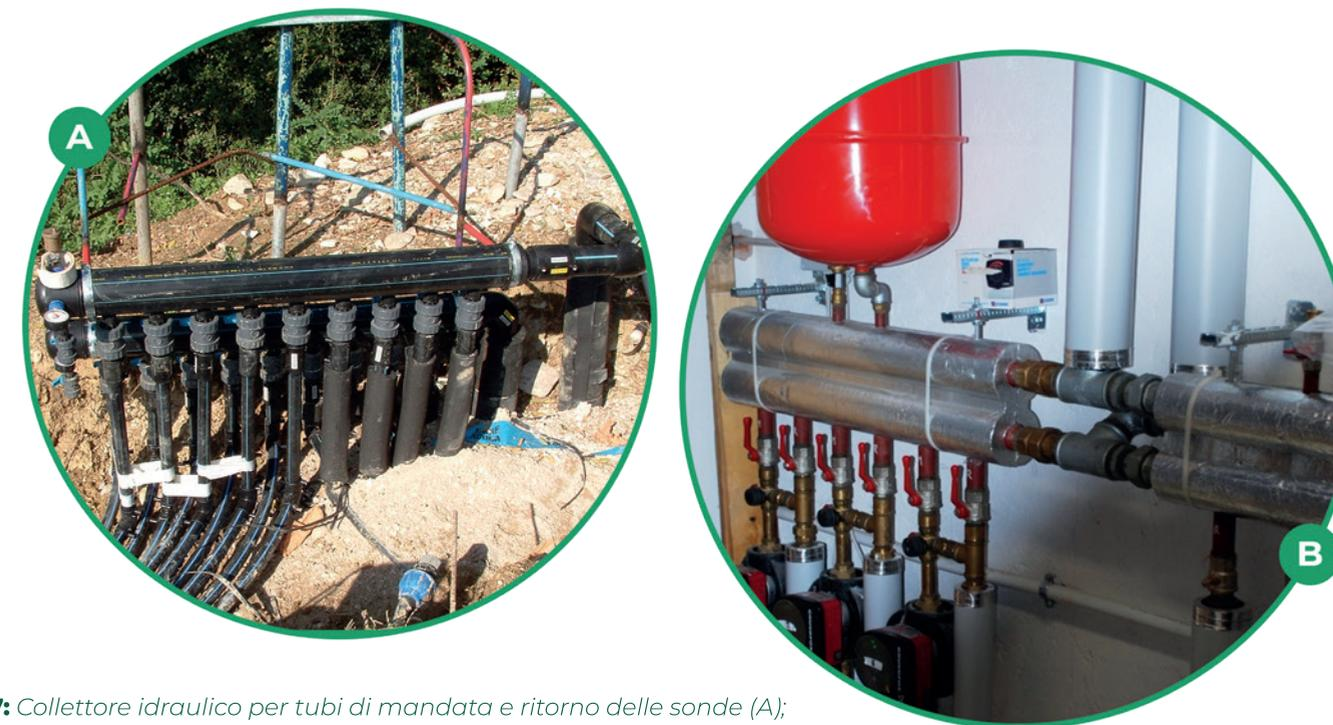
**Fig. 7:** Collettore idraulico per tubi di mandata e ritorno delle sonde (A); pompe di circolazione (B).
