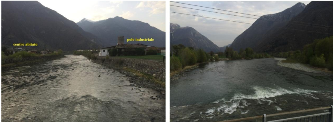
Figura 2.26 – A sinistra tratto arginato in corrispondenza del polo industriale e del centro abitato di Verrès (foto Borinatto, scattata dal ponte sulla strada regionale n°4 nei pressi della Fraz. Les Garines, vista verso monte); a destra sponde naturali (foto Borinatto, scattata dal ponte sulla strada regionale n°4 nei pressi della Fraz. Les Garines di Verrès, vista verso valle).
