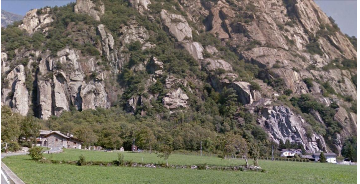
Figura 2.3 – Pareti rocciose con giacitura subverticale nei pressi della frazione Prouve nel comune di Arnad (foto Borinatto).
