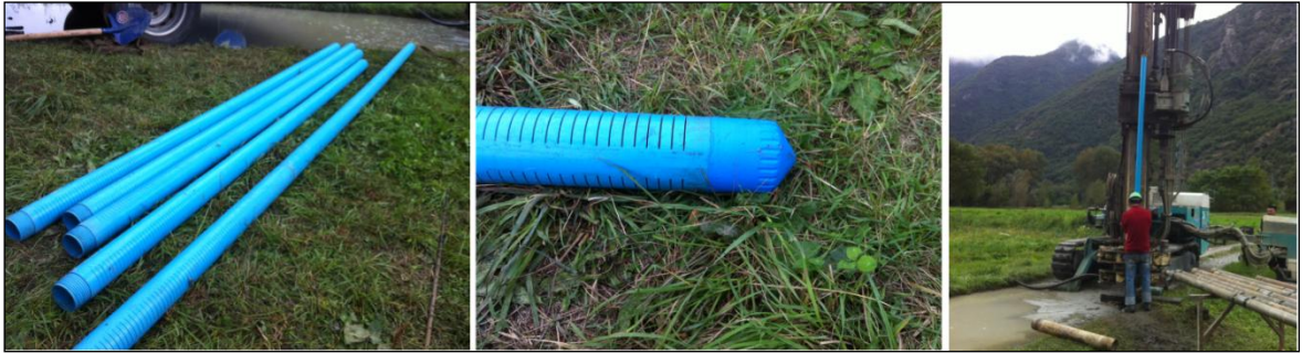
Figura 4.8 – A sinistra segmenti di lunghezza 3 m della colonna tubolare in PVC; in centro parte del tratto finestrato con fessure di 1 mm e tappo conico che chiude la parte inferiore della colonna in PVC; a destra inserimento della colonna in PVC nel foro (foto Borinatto).
