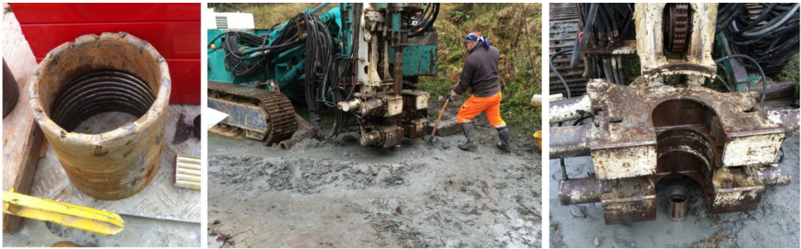
Figura 4.5 – A sinistra: scarpa; in centro: inserimento della colonna di rivestimento; a destra: colonna di rivestimento inserita nel foro (foto Borinatto).
