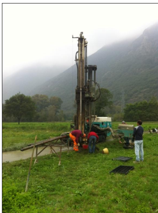
Figura 4.2 – Cantiere di perforazione del sondaggio nel comune di Verrès (foto Borinatto).
