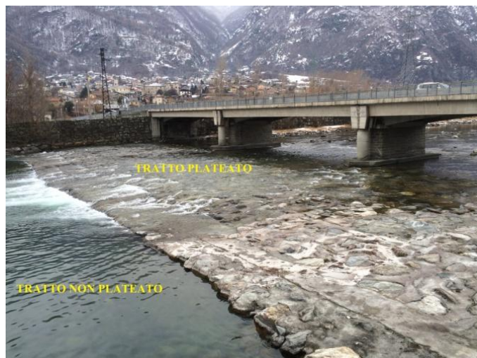
Figura 2.27 – Tratti di fondo non plateato e plateato al ponte sulla strada regionale n°4 nei pressi della Fraz. Les Garines di Verrès (foto Borinatto).
