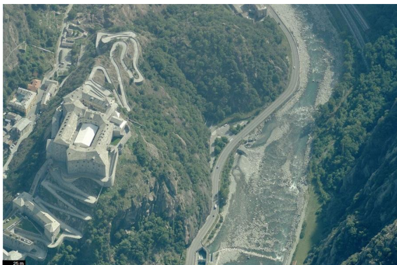
Figura 2.29 – La stretta di Bard (vista da monte, in basso, verso valle, in alto) rappresenta la chiusura dell'area di studio. Il fondovalle, molto stretto (circa 150 m) è delimitato da versanti in roccia con giacitura sub verticale. Sul versante orografico sinistro è presente il borgo di Bard dove è ben visibile il famoso Forte (rif. Web n.2).
