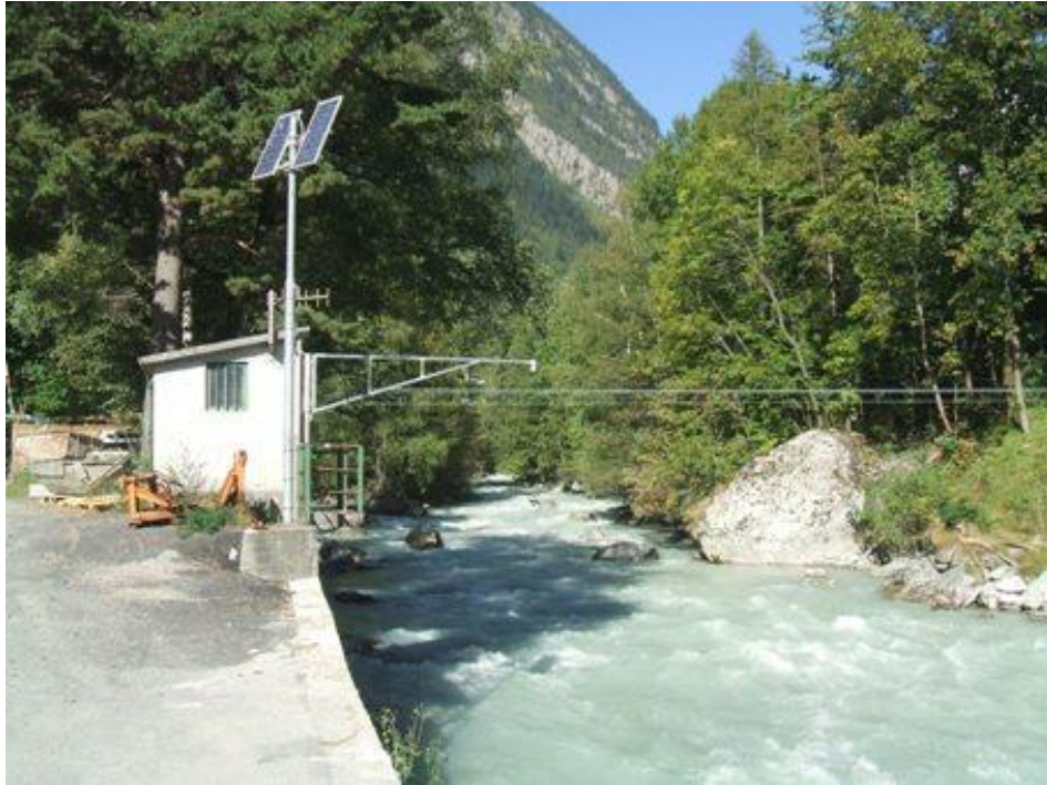
Figura 2.19 – Stazione di misura della portata di Pré-Saint-Didier.
