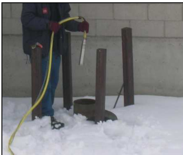
Figura 4.88 - La pompa idrosommersibile viene calata all'interno del tubo piezometrico.
