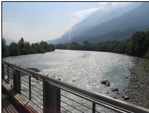
Figura 4.80 – Passerella di Gressan (vista verso valle).
