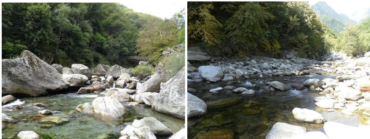
Figura 20: sito di monitoraggio AYS050 sul torrente Ayasse prima (2020, a sinistra) e dopo (2022, a destra) i lavori di sistemazione dell'alveo.
