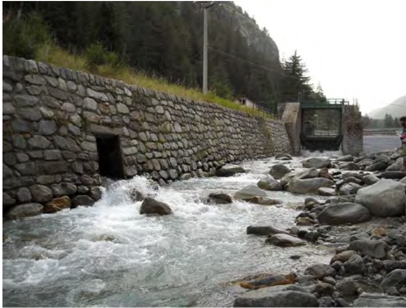
Fig. III. 21– Torrente Savara, tratto a valle delle presa di Fenille.
