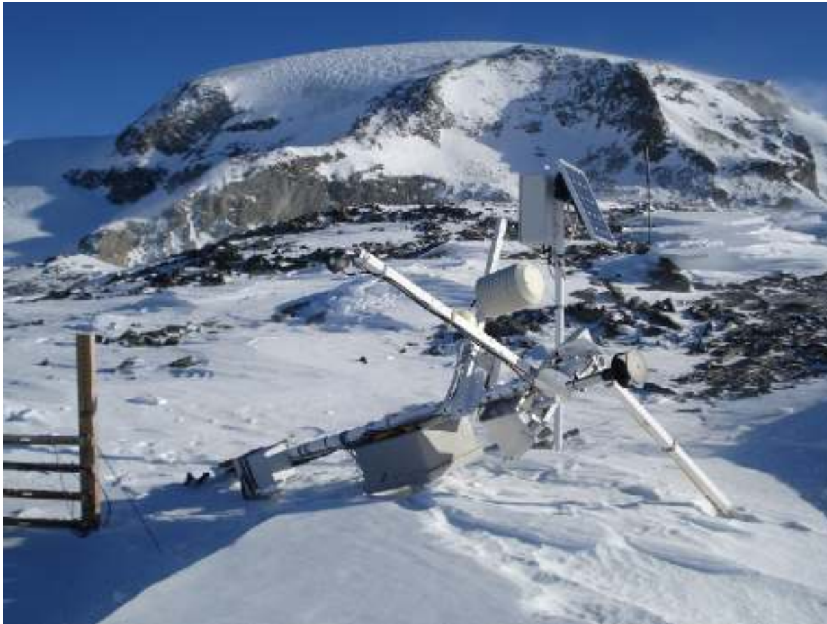
07 gennaio 2012 - Stazione meteo ARPA VDA di Cime Bianche abbattuta dal vento
