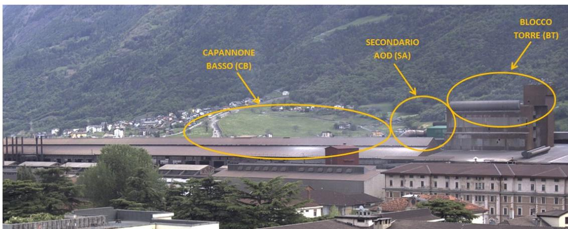
Figura 10 – Vista del reparto acciaieria dello stabilimento CAS acquisita dalla telecamera con indicazione delle tre diverse zone di uscita delle emissioni diffuse
