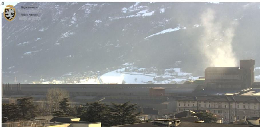
Figura 13 – Evento diurno di emissione diffusa proveniente dal blocco torre di intensità 3-elevata (BT3)
