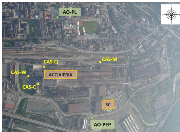
Figura 1 – Siti di misura delle deposizioni atmosferiche all'interno dello stabilimento CAS con indicazione del reparto acciaieria e del reparto trattamento scorie che costituiscono le principali fonti di emissione diffusa di polveri. AO-PEP (Aosta-Pépinère) e AO-PL (Aosta-Plouves) sono siti di misura delle deposizioni atmosferiche sul territorio urbano
