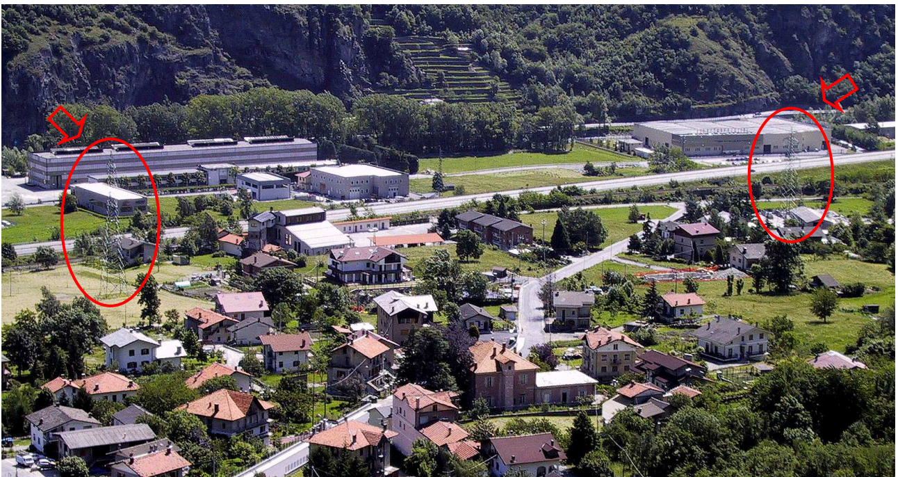
Foto 1 : Comune di Champdepraz, località Fabrique – tralicci elettrodotto linee 210 –215.
