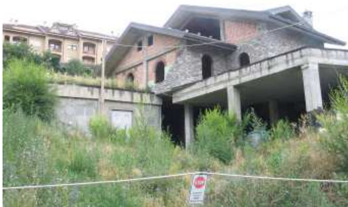
a) edificio vicino a cabina MT/BT
