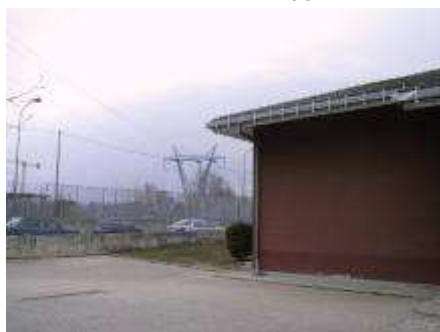
Figura 1 – Edificio scolastico interessato dal passaggio di linea AT e da linea interna interrata
