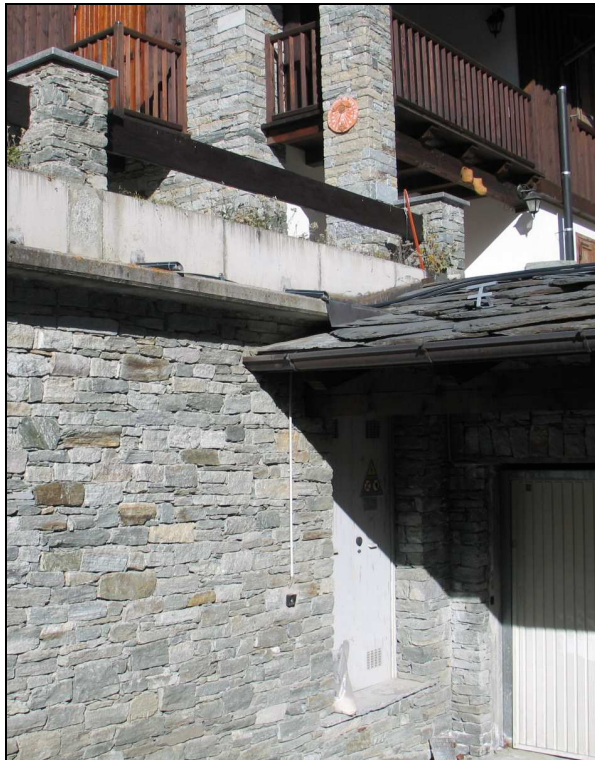
Figura 2 – Cabina urbana alimentata in cavo interrato posta al piano seminterrato di una abitazione civile.
