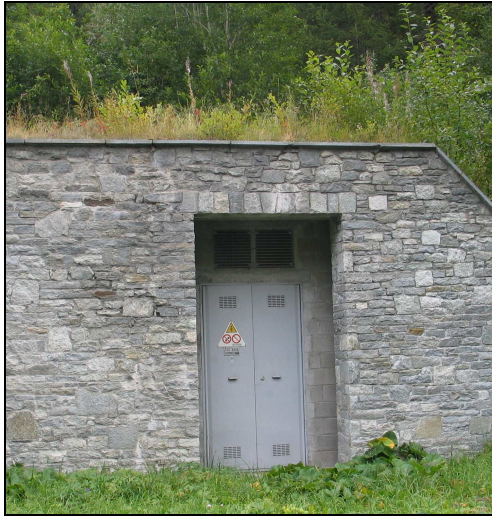
Figura 1 - Cabine MT/BT in muratura; a sinistra, cabina per alimentazione da cavo interrato; a destra, cabina per alimentazione da linea aerea.
