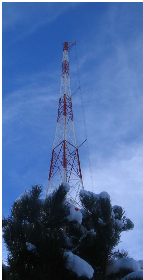
Figura 4: antenna filare per radio in OM
