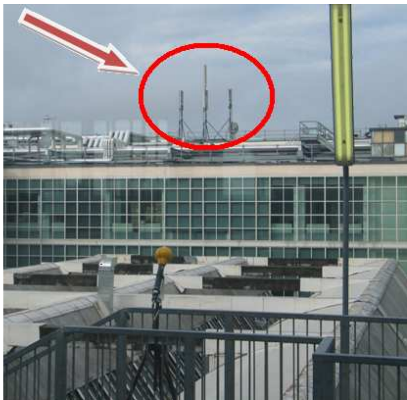
Figura 8.1.3 - Sito di Ivrea (TO)
