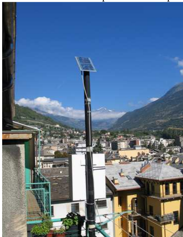
Foto 2 a e b – Esempi di collocazioni di centraline di monitoraggio prolungato del campo E
