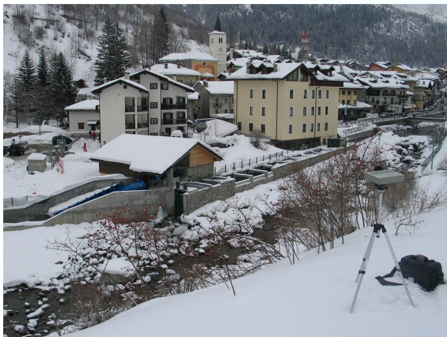
Centrale di La Thuile Capoluogo (Centrale 1)
