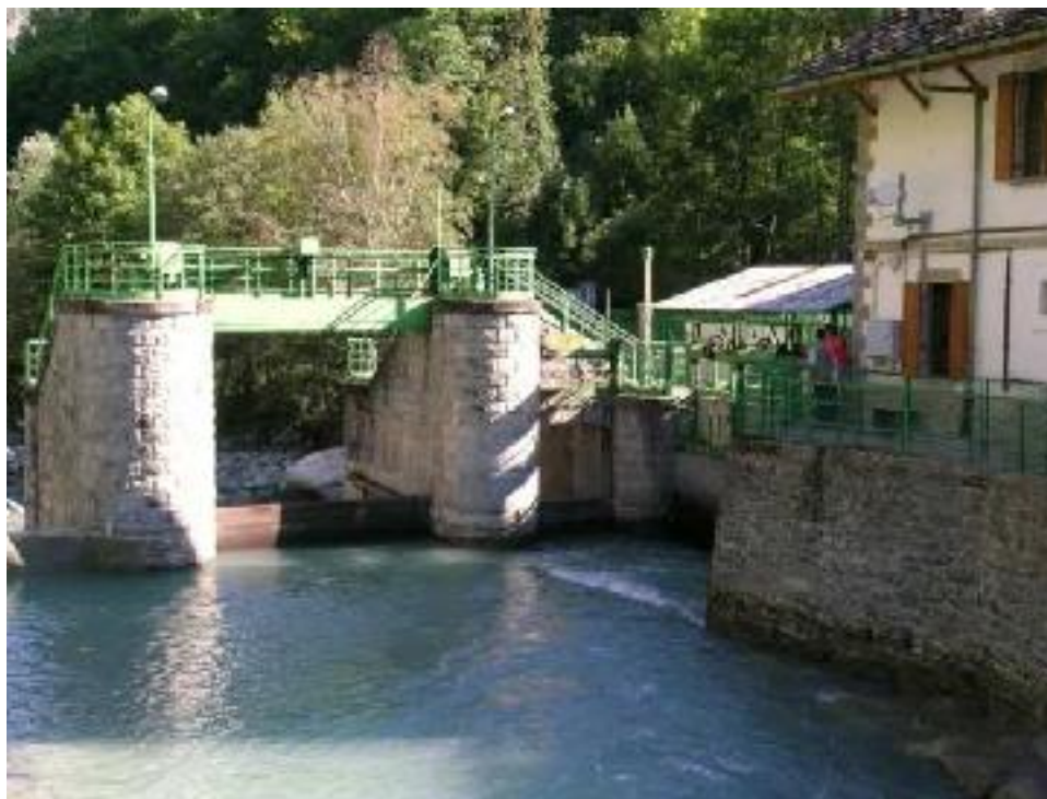
Figura 3.9 - Presa sul torrente Dora di Rhemes
