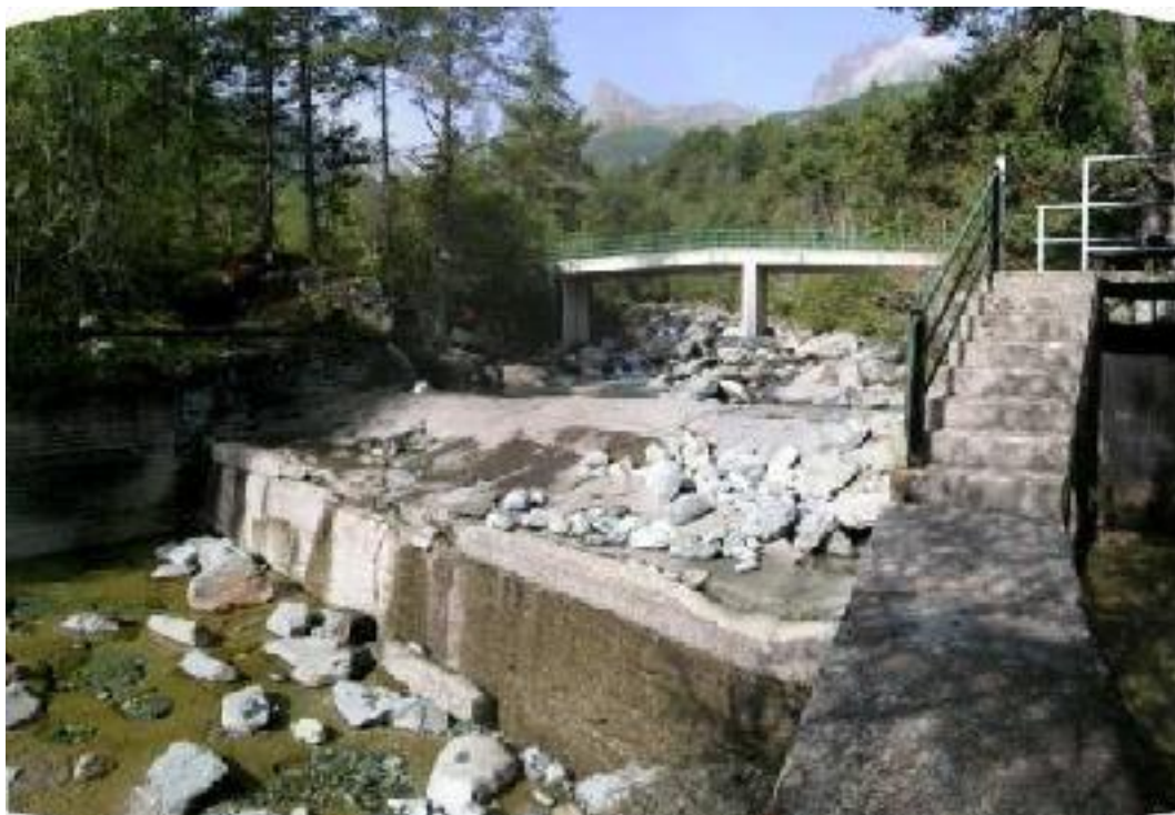
Figura 3.7 - Sbarramento di Chevrères sul fianco sinistro la paratoia sghiaiatrice per il rilascio del DMV
