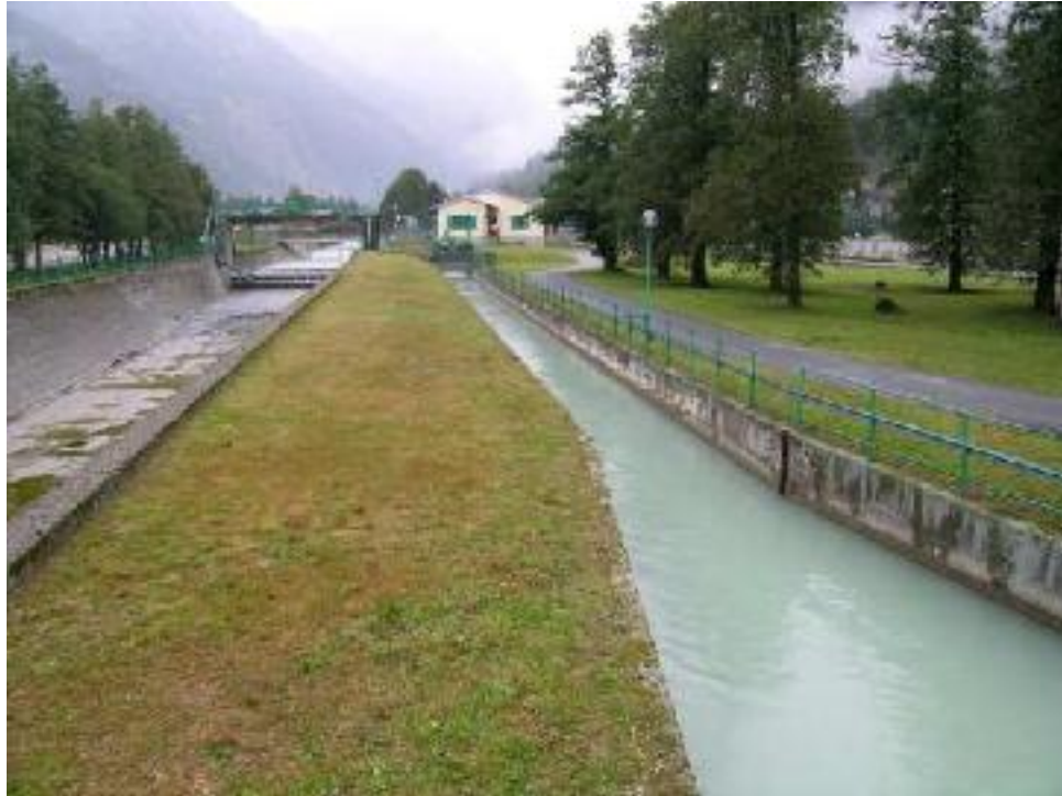
Figura 3.13 - Presa sul torrente Lys (Bielciuken)
